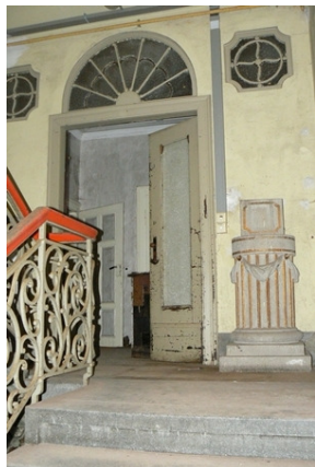
15 Tür ausbauen, einlagern.
