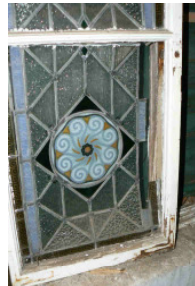
Fotos Bleiglasfenster im Bad (Bestand)
