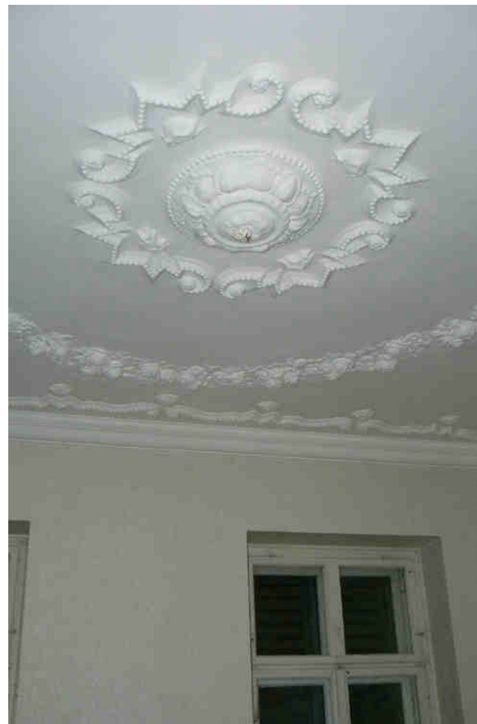
EG Raum 04 mit Rosendecke heute
