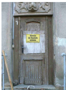
Details vom heutigen Zustand: Haustür und Aussentreppe
