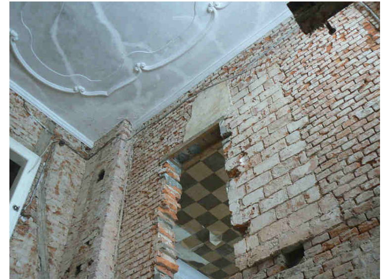
Decke im 1. OG - Raum 08 "Wohnzimmer" (Decke zwischen EG und 1. OG entfernt)
