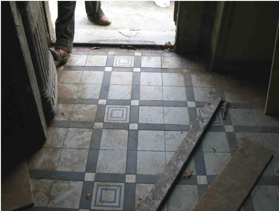
EG Raum 11 - Windfang im Bestand: mit originalem Fußboden, mit Wand/ Natursteinverkleidung wandhoch (Schiefertafel und Bronzefassung?) und Kassettendecke
